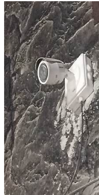
Cámara de video vigilancia usando el servicio de Streaming en Taller de Trackless N14, a 5Km de distancia.
